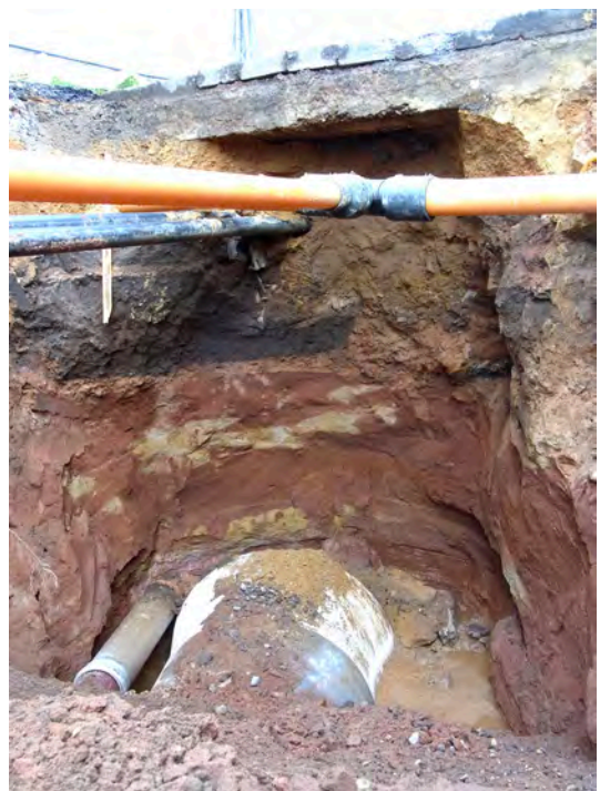
Abb. 37. Kanalgraben im Kreuzungsbereich Hauptstraße und Schlachthausweg. Über dem anstehenden mittleren Buntsandstein liegt eine dünne Aufarbeitungsschicht des Sandsteins, darüber eine deutlich dunkle, also humose Lage. Vergrößerung der Abbildung im Anhang S. 57.
