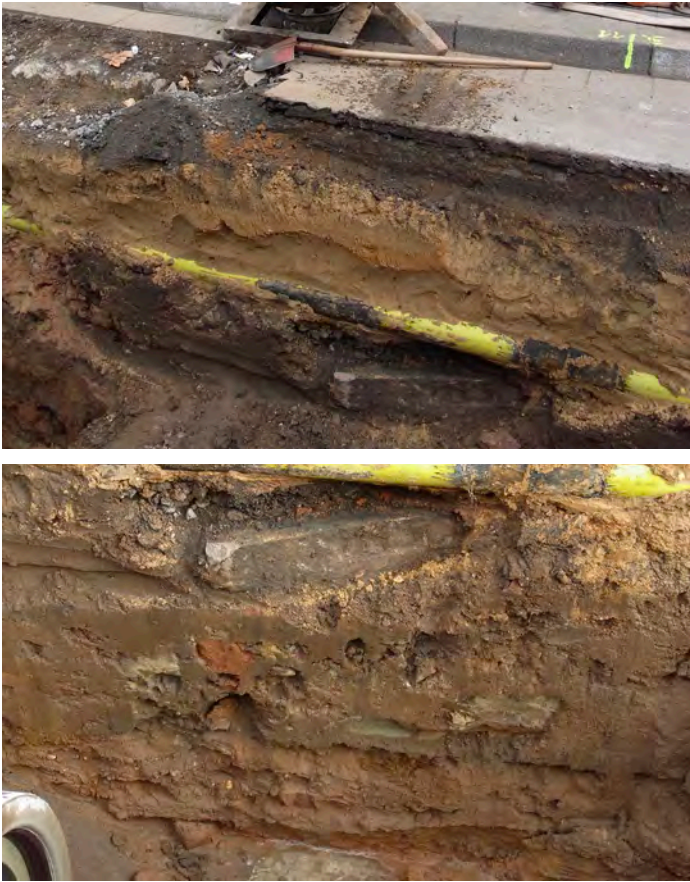
Abb. 29. Profil im Bereich der Furt beim ehemaligen Haus 19 in der Hauptstraße. Es wurden zwei Fotos kombiniert. Das obere zeigt das Profil vom Randstein bis zur Gasleitung. Direkt unter der Leitung ein letzter Rest der in die heutige Straße reichende Ecke des Hauses 19 (nicht unterkellert). Das untere (in größerem Maßstab setzt das Profil fort. Direkt an der Bildkante kann man eine Steinplatte erkennen, die zur Furt gehörte. Die Abfolge über der Furt zeigt zunächst geschichtete Sande, die nach oben eher lehmig werden. Die Sande über der Leitung sind in den Leitungsgraben eingefüllt. Vergrößerung der Abbildung im Anhang S. 56.
