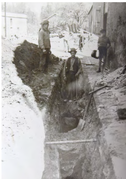
Abb. 17. Turm-Fundament im Mühlenweg. Foto aus dem Nachlass Liebertz im Kreisarchiv Saarlouis. Der Scan ist unbearbeitet. Mit Bearbeitung lassen sich viele Details der Umgebung besser darstellen, aber nicht die eigentlichen Mauern. Vergrößerung der Abbildung im Anhang S. 46.
