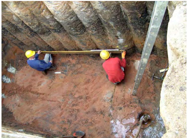
Abb. 9. Drosselschacht in der Dreimarienstraße. Wand aus Betonpfählen, an denen noch die Füllung des Stadtgrabens zu erkennen ist. Die Sohle besteht aus dem anstehenden mittleren Buntsandstein. Darüber folgt die untere (Faul-)Schlammsschicht (durch die Richtlatte etwas verdeckt), weiter eine untere Sandschicht, darüber die obere (Faul-)Schlammsschicht und dann die obere Sandschicht. Vergrößerung der Abbildung im Anhang S. 45.
