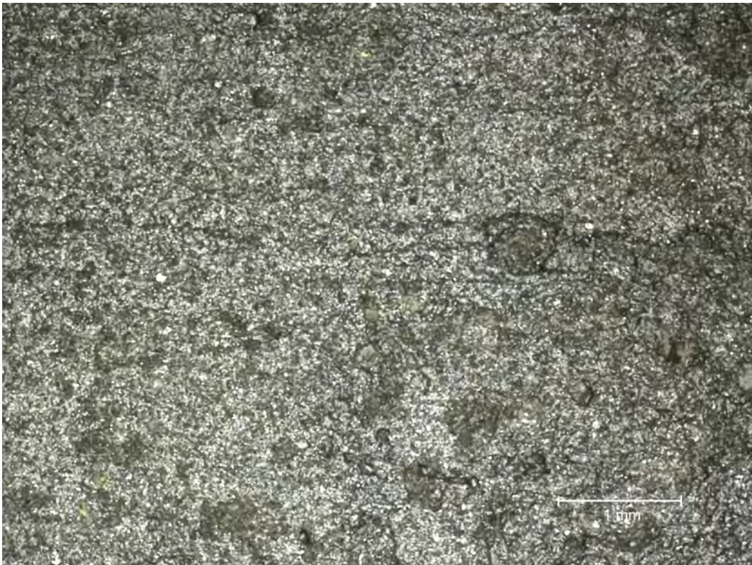
Bild 3/FK 33: Oberfläche Außenseite
