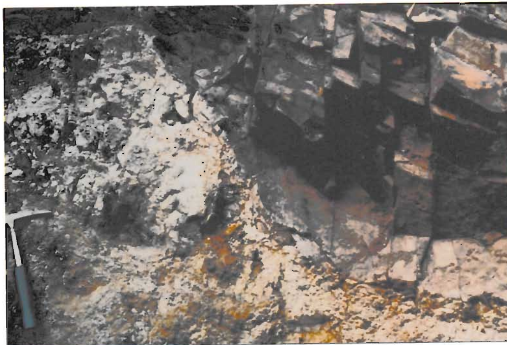
Abb. 12: Dargestellt ist die "lehmige" Umwandlung des Latiandesits Typ Steinkaulenberg. Im oberen Bereich des Bildes ist der noch scheinbar intakte Gesteinsverband zu sehen. Bei geringer mechanischer Beanspruchung zerfällt das Gestein wie im unteren Teil des Bildes. Im rechten unteren Teil ist der Übergang besonders deutlich zu erkennen (Edelsteinminen Steinkaulenberg) (SCHMIDT 1986).
